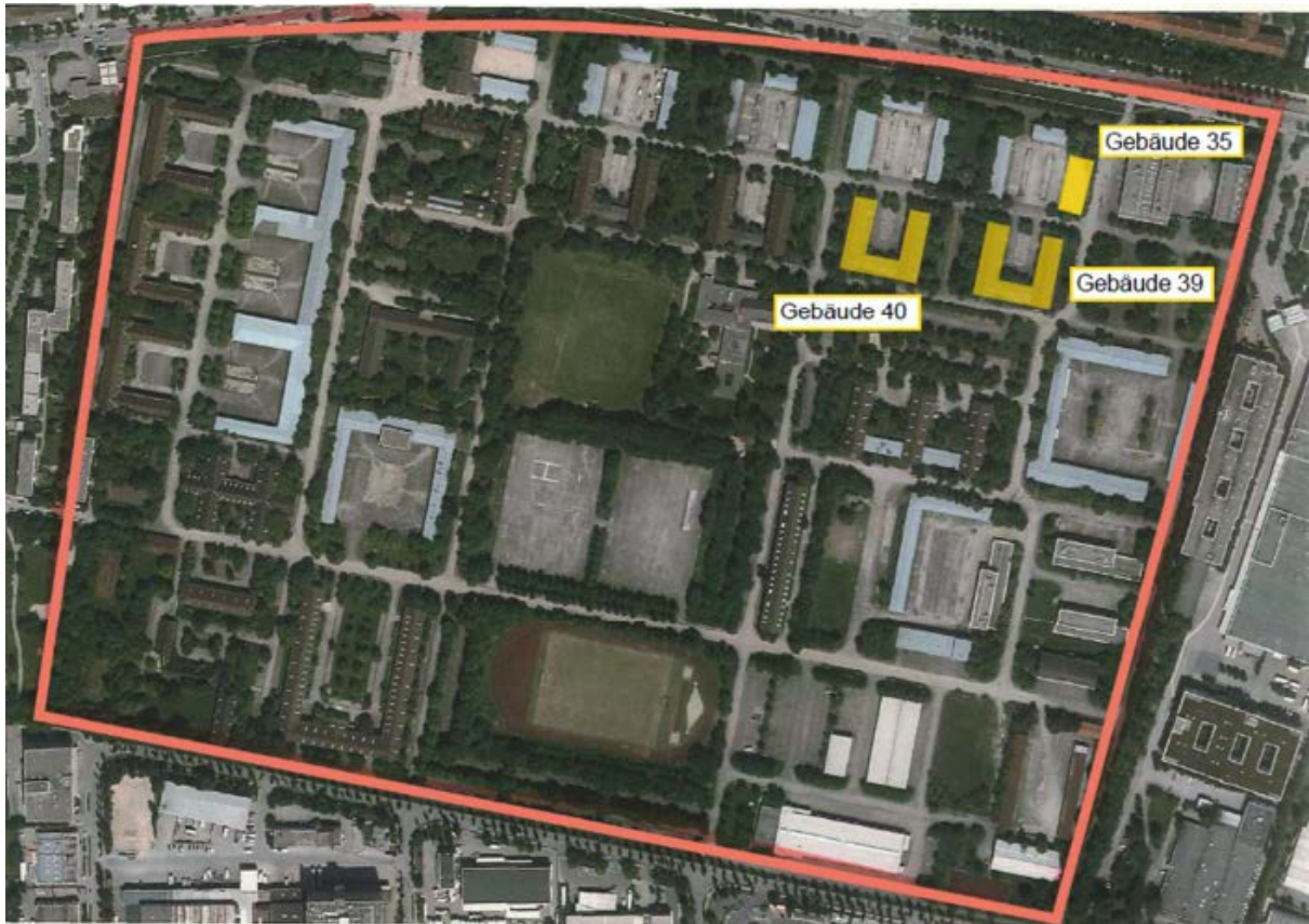
Abbildung 1: Ehemalige Bayernkaserne - Markierung der Abbruchgebäude dieser Studie (gelb)
