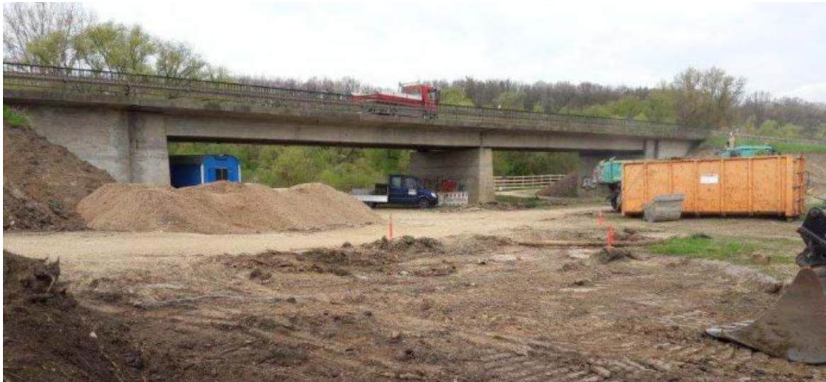
Abbildung 8: Aufnahme der abzubrechenden Mainflutbrücke an der B279 zwischen Breitengüßbach und Baunach (Quelle: Fa. RAAB Baugesellschaft mbH & Co KG)
